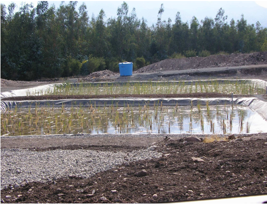
Abb. 2 Constructed Wetland am Standort der Kupfermine in Chile (erstes Quartal 2007)
